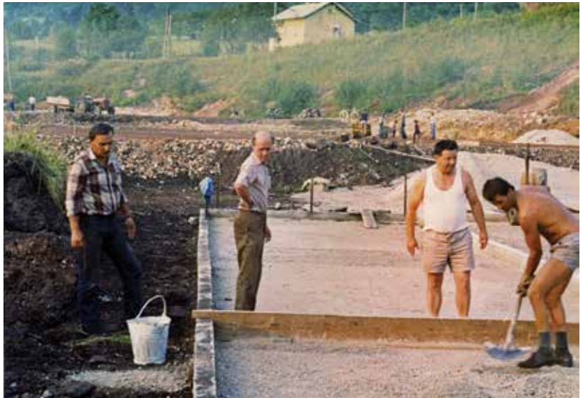
Izgradnja igrišča za balinanje leta 1979, v ozadju vidna izgradnja teniških igrišč
